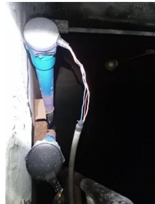
อิเล็กโทรดวัดระดับน้ำ Electrode Water Level)
