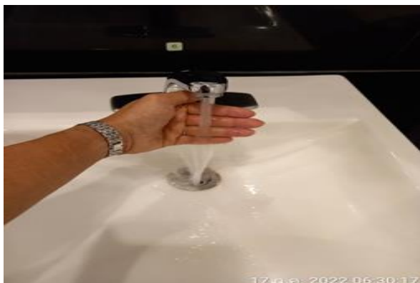
ติดตั้งก๊อกน้ำระบบ Sensor
