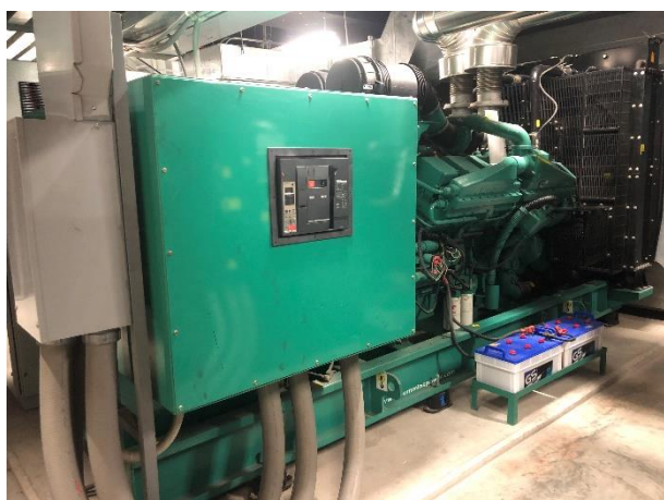
เครื่องกำเนิดไฟฟ้าสำรองฉุกเฉิน (ขนาด 1,000 KVA จำนวน 1 ชุด
