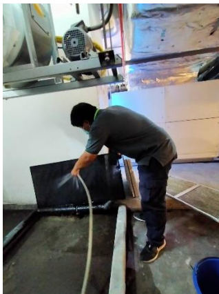
จัดแผนล้างทำความสะอาดแผ่นกรองเดือนละ 1 ครั้ง
