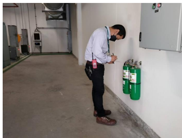
ติดตั้งถังดับเพลิงมือถือบริเวณโถงบันไดและห้องเครื่องไฟฟ้า
