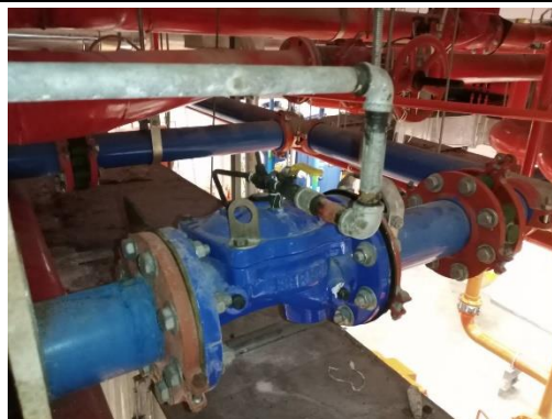
ระบบ โฟลทวาล์ว (Float Valve)
