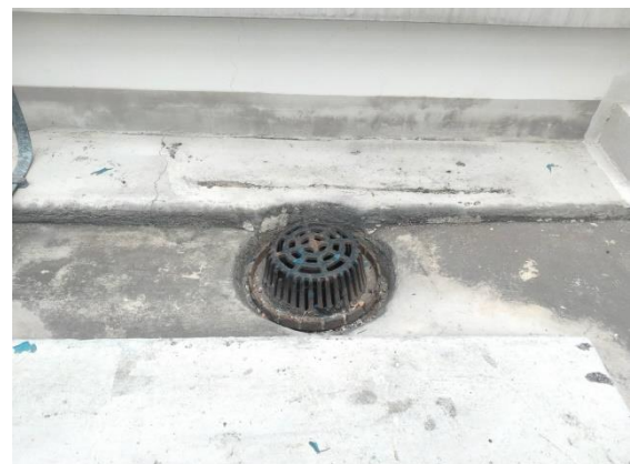
ใช้ตะแกรงครอบท่อและตรวจสอบท่อระบายน้ำประจำวัน
