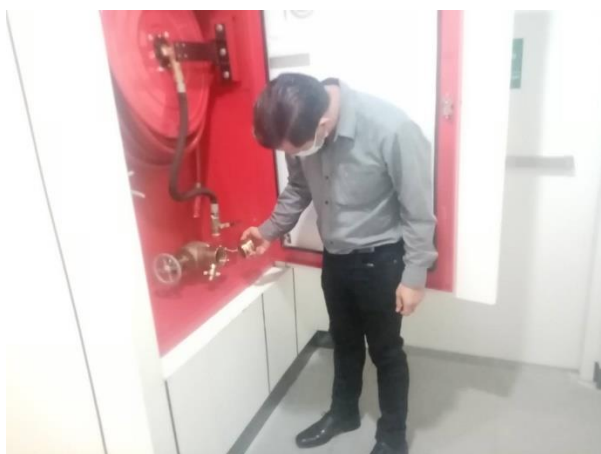
ตู้เก็บสายฉีดน้ำดับเพลิงพร้อมอุปกรณ์ (Fire Hose Cabinet : FHC) พร้อมอุปกรณ์ไว้ในอาคาร
