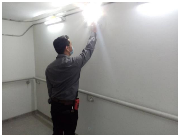
การตรวจสอบป้ายหนีไฟ, อุปกรณ์ส่องสว่างตามแผนงาน
