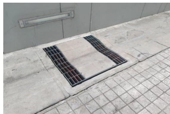
ใช้ตะแกรงครอบท่อและตรวจสอบท่อระบายน้ำประจำวัน
